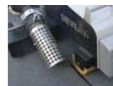
Lassen van gemodificeerd bitumen
